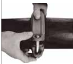
5. Kaplin gövdesi kurulumu Housing installation
