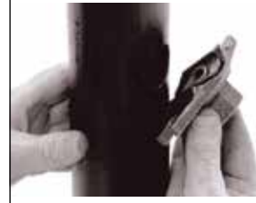
3. Conta montajı Gasket installation
