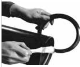
2. Contayı yağlayın Lubricate gasket
