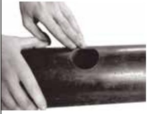
1. Boru hazırlığı Pipe preparation
