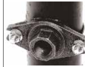
6. Montaj tamamlandı Assembly completed
