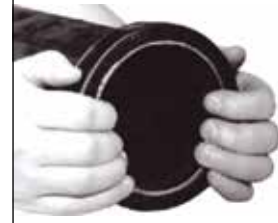
3. Conta montajı Gasket installation
